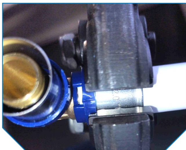
Przyłożenie szczęki „U” do złączki na rurze o średnicy 20 mm. Widok 2 w zaciskarce.
